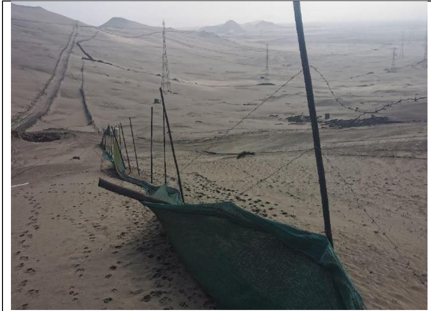
Fotografía N° 5: Vista panorámica del acceso principal (trocha carrozable) en dirección oeste a este, se inicia en el Km 44.15 de la carretera Panamericana Sur.
