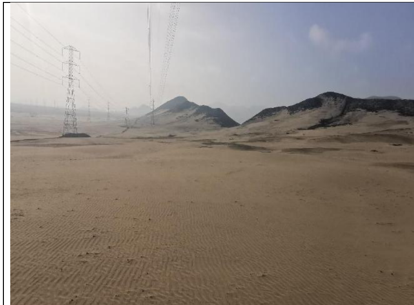
Fotografía N° 2: Vista de la servidumbre de electroducto que cruza el predio en dirección Sur a Norte
