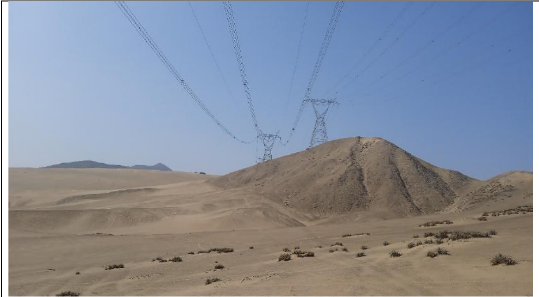
Fotografía N° 5: Vista panorámica del predio "Sección 226" en dirección sur. Se observa los electroductos de la LTE de 220 kV y 500 kV que cruzan el predio en dirección norte sur.
